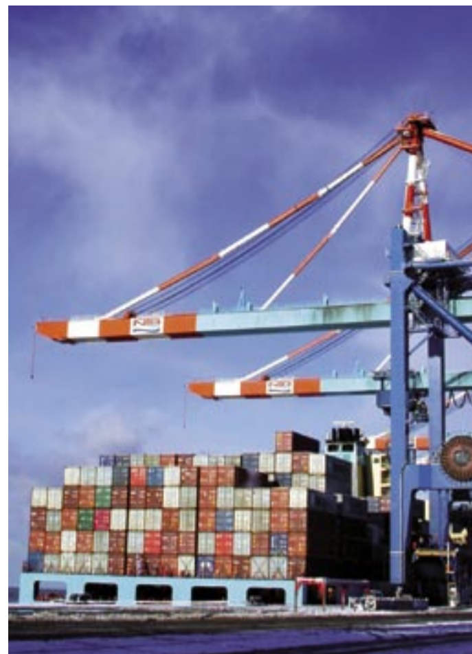
Die Containerbrücken von NTB liefern auch Strom. Bild: Archiv
