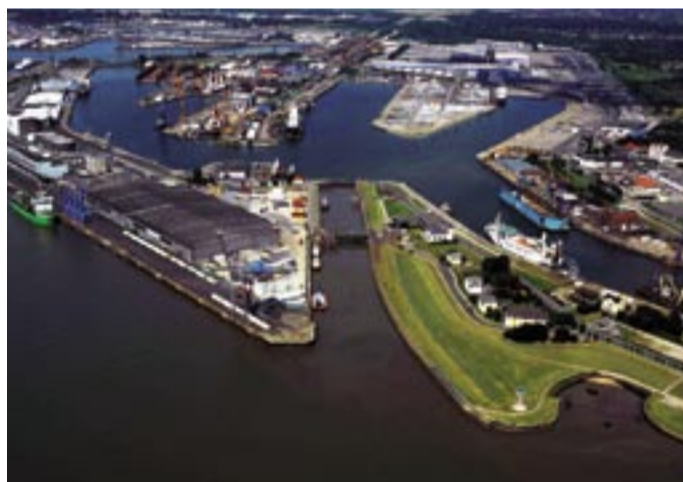
Die Kaiserschleuse in der aktuellen Ausbaustufe.
